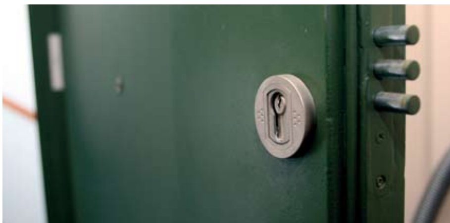
Entreprenøren har heller ikke sørget for FG-godkjente låser.
