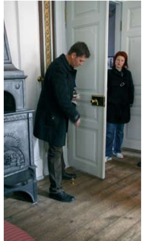
Ledaal har enestående fransklåser. 30 av disse har fått "nytt liv" i Hvedings kjeller i forbindelse med en stor restaurering på bygget. Sivilarkitekt Live Gram, en av distriktets flinke bygningsvernere, i bakgrunnen.
