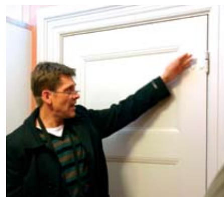
Bård Eilif viser kopier av innstikkshengsler, typisk for 1700- og tidlig 1800-tallet
