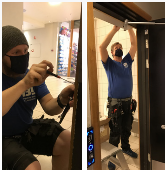
Henrik Olsson og Idar Hansen monterer berøringsfrie alubuebrytere
